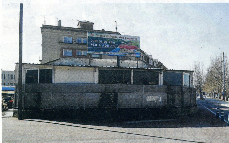
Imatge de l'edifici que serà enderrocat, ahir al matí. FOTO: JOAN REVILLAS
