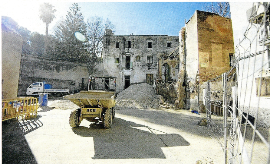
Imatge dels treballs al Balneari del Porcar, ahir al matí. FOTO: JOAN REVILLAS
