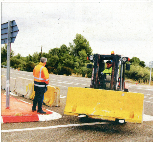
Treballs previs a la construcció d'una rotonda a l'Almadrava. / ACN
