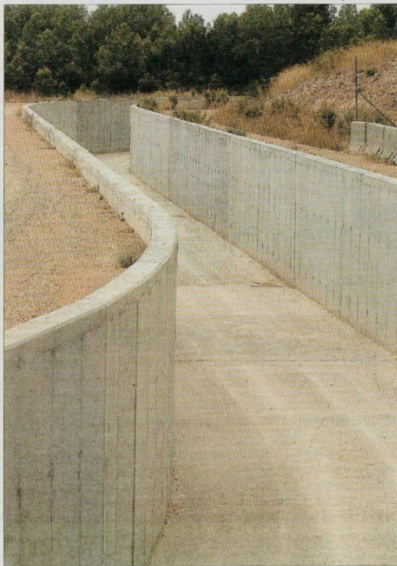
La major part del canal principal de regadiu ja ha estat remodelat.
