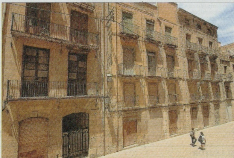
Dels sis blocs d'habitatges del carrer Croera afectats per l'enderroc quatre han estat tapiats. FOTO: JOAN REVILLAS
