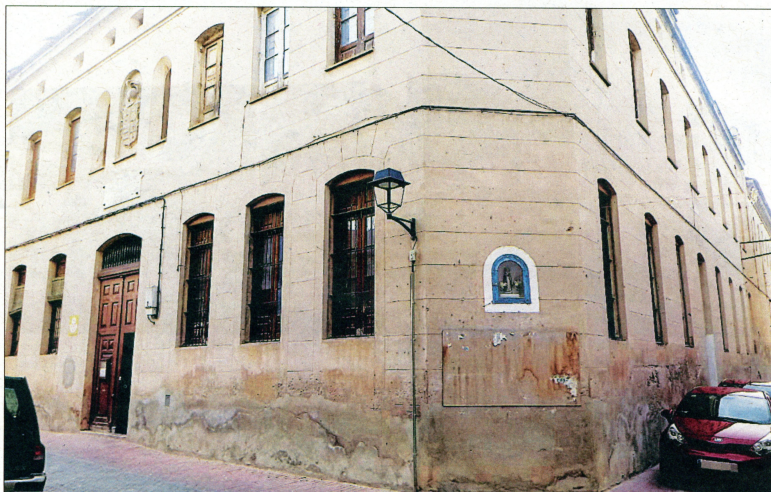
Imatge d'un dels accessos a l'edifici de l'antic convent. / S.G.
