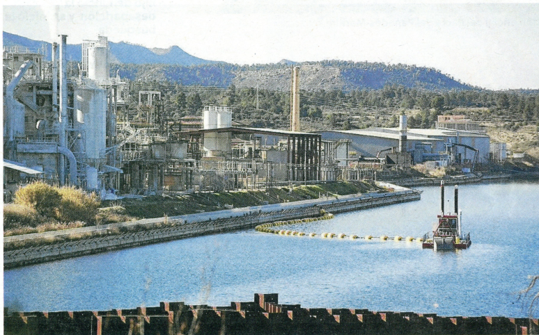
Imatge de la draga instal·lada al mig del pantà de Flix, ahir. FOTO: JOAN REVILLAS
