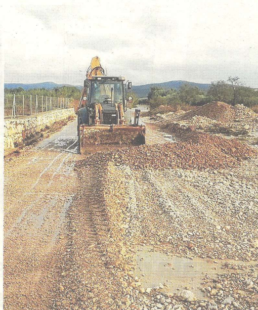
Màquina treballant en un camí d'Ulledecona. FOTO: AJUNTAMENT D'ULLEDECONA
