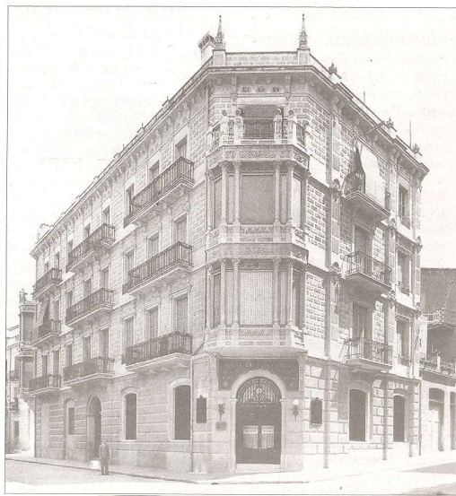
El segon edifici que va ocupar la Caixa de Pensiones quan va arribar a Tortosa, d'inspiració modernista adequat a l'arquitectura de l'"Ensanxe" fou malmès el 1964 per ampliar el seu estatge tal com ha quedat ara.
