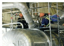
Tareas de mantenimiento y mejora. FOTO: ANAV
