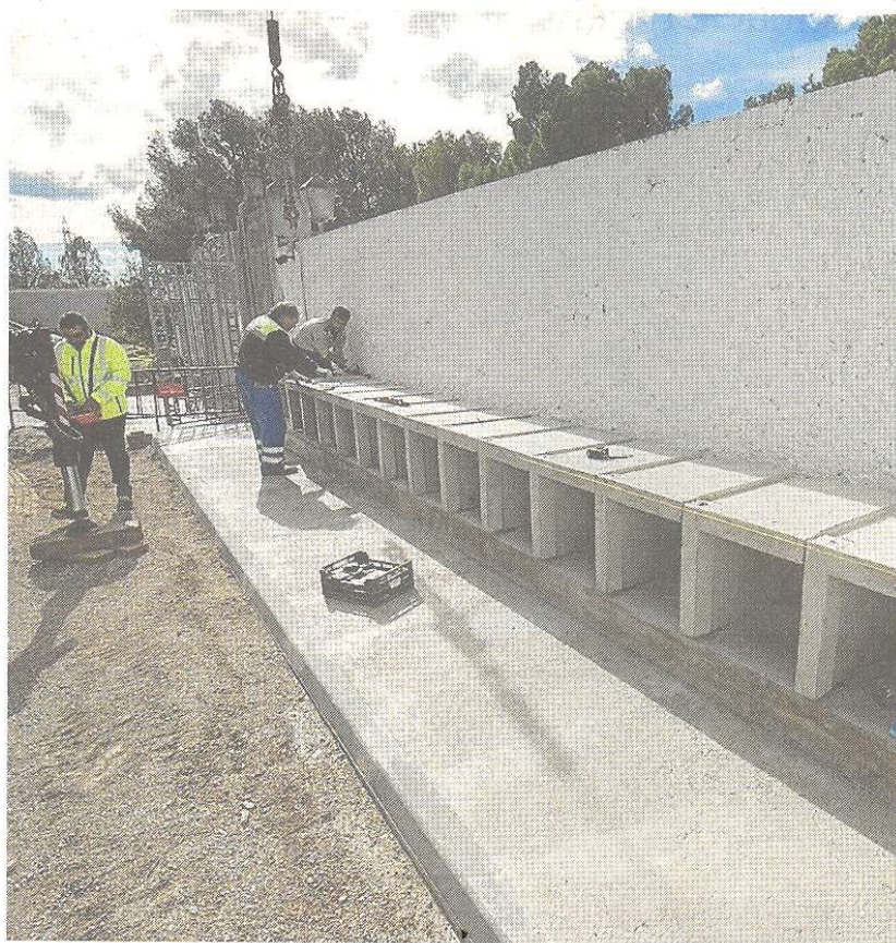
Els operaris treballant en la construcció, ahir. FOTO: JOAN REVILLAS
