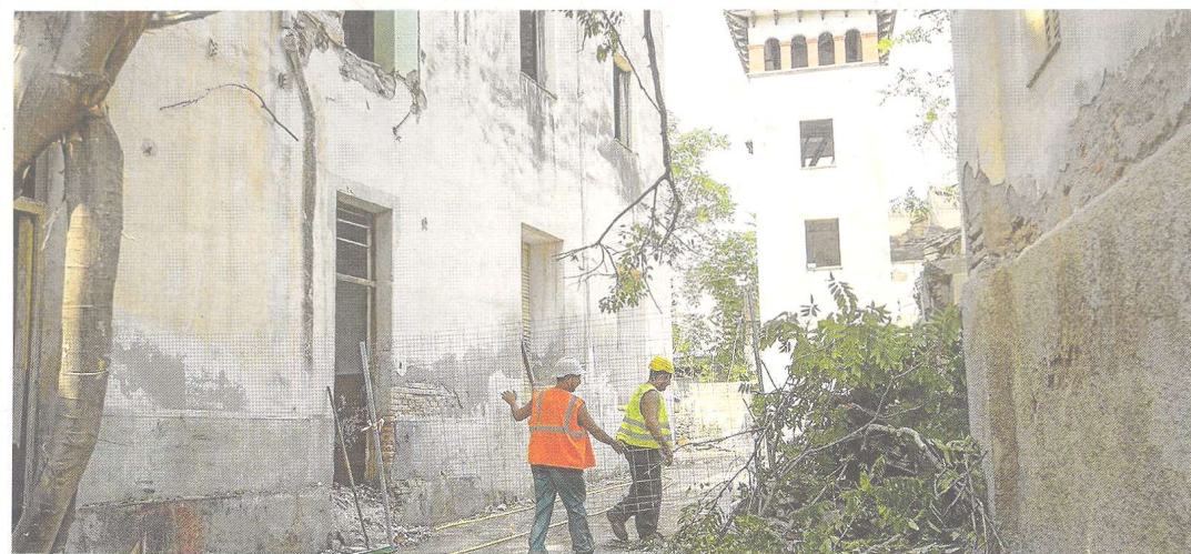
Dos operaris, treballant en els enderrocs previstos en l'obra, ahir. FOTO: JOAN REVILLAS
