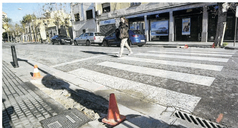
Avinguda Germans Carsi, un dels llocs on s'estan duent a terme les actuacions. FOTO: JOAN REVILLAS
