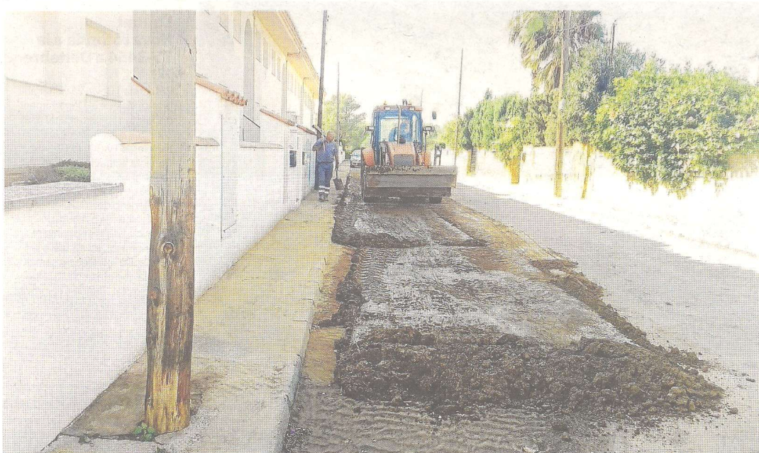
Un dels camins afectats pel temporal on s'han iniciat les obres provisionals de reparació. FOTO: AJUNTAMENT D'ALCANAR
