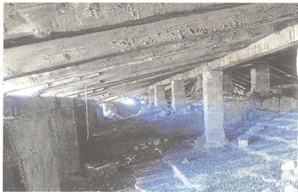
Imatge d'arxiu de l'interior de la teulada de l'església de Sant Joan Baptista, abans d'iniciar-se les obres. FOTO: JOAN REVILLAS
