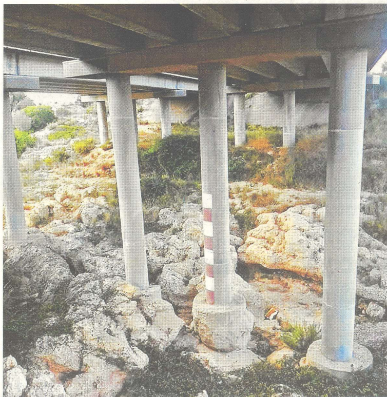
Imatge del pont sobre el barranc de Barbiguera, a Vinaròs. FOTO: CEDIDA
