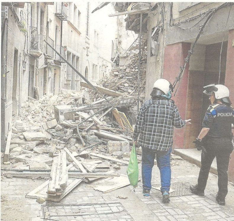
Los escombros de las dos casas derrumbadas ocupan a lo ancho la calle Moncada. FOTO: JOAN REVILLAS
