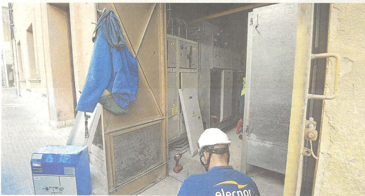
Operaris reparant l'avaria elèctrica de la setmana passada a Tortosa. FOTO: JOAN REVILLAS
