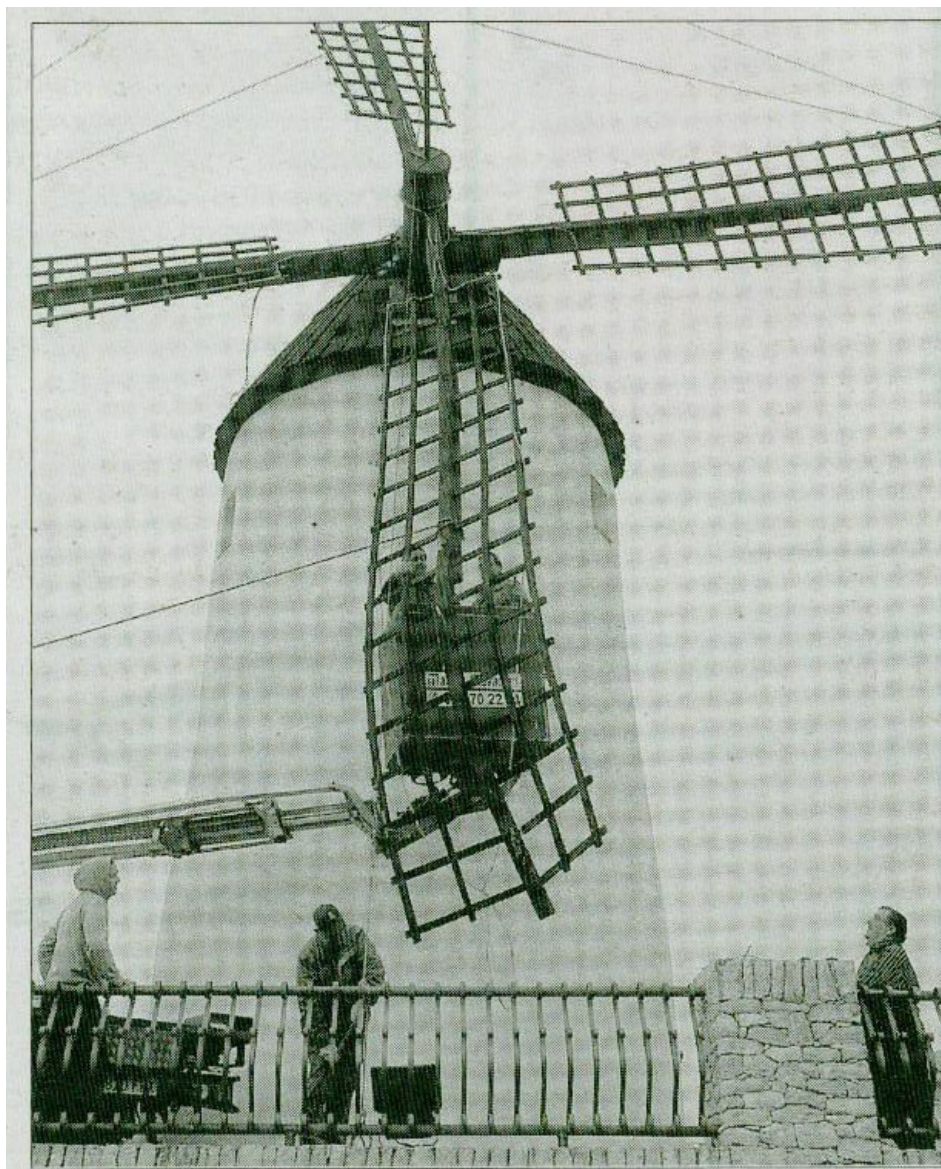
► Diversos operaris reparant una aspa del molí 'quixotesc', ahir al matí, al municipi del Perelló. FOTO: JOAN REVILLAS
