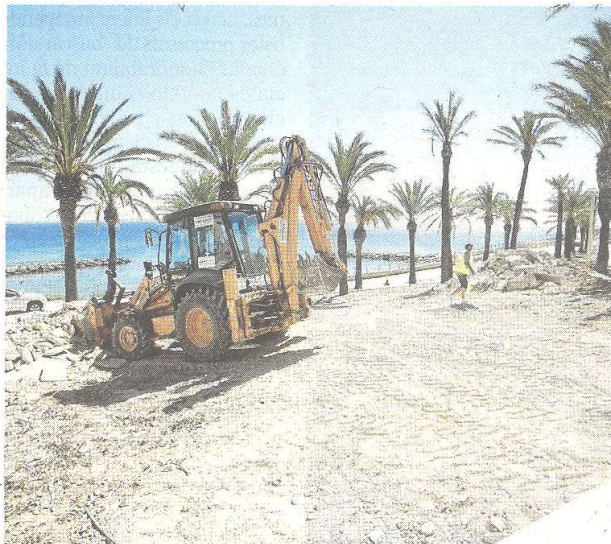
Màquines i operaris treballant en aquesta obra de Ports de la Generalitat. FOTO: JOAN REVILLAS
