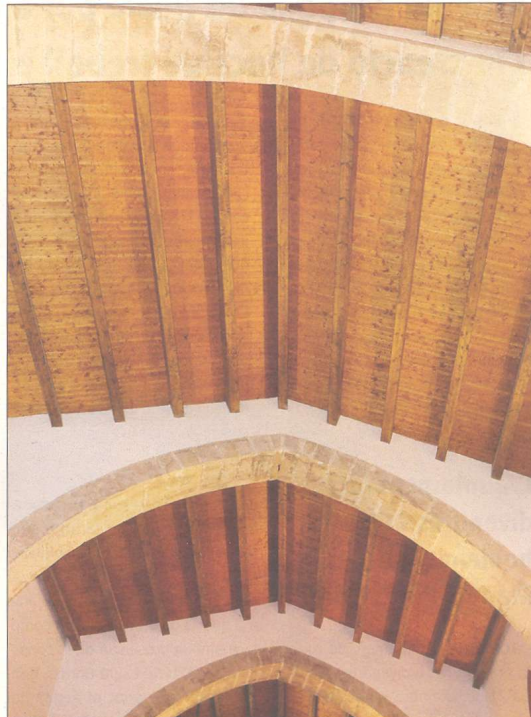
Imatge del sostre de la capella, ja rehabilitat. / N.C.
