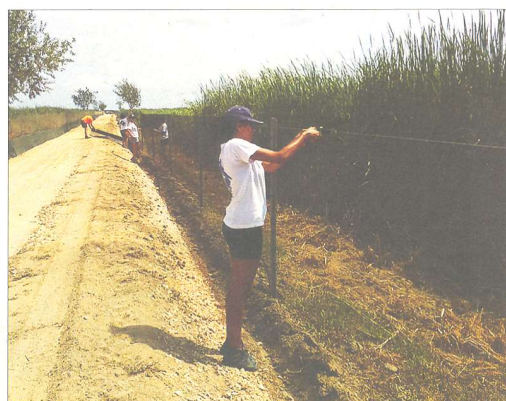
Imatge de la tanca perimetral que han estat construït voluntaris del Parc i treballadors de Forestal Catalana. / CEDIDA
