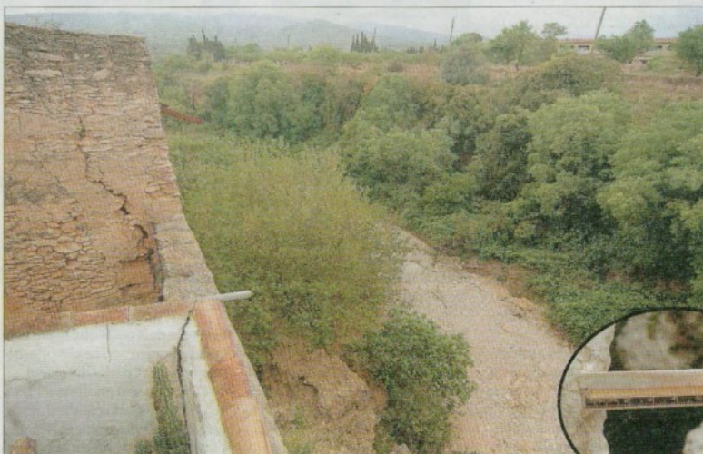
Els murs d'algunes cases situades al peu del barranc de la Galera mostren grans esquerdes. A la imatge de detall se'n pot veure l'amplada. FOTO: JOAN REVILLAS
