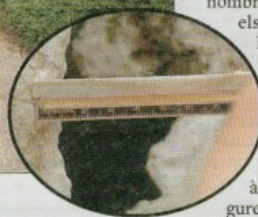
Els murs d'algunes cases situades al peu del barranc de la Galera mostren grans esquerdes. A la imatge de detall se'n pot veure l'amplada. FOTO: JOAN REVILLAS
