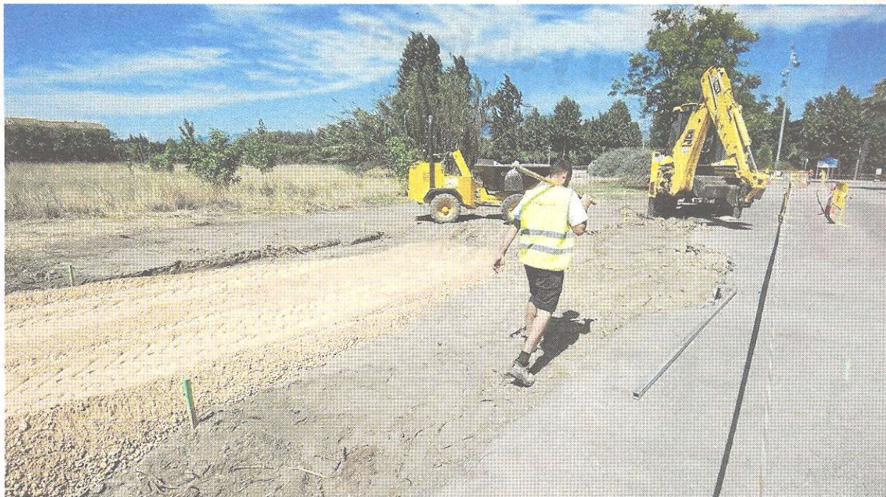
Les obres les executa l'empresa Exxaber SL i ja estan en marxa. FOTO: JOAN REVILLAS
