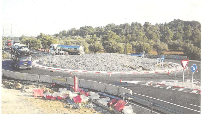
Una de las rotondas ya construidas en la N-340. FOTO: JOAN REVILLAS
