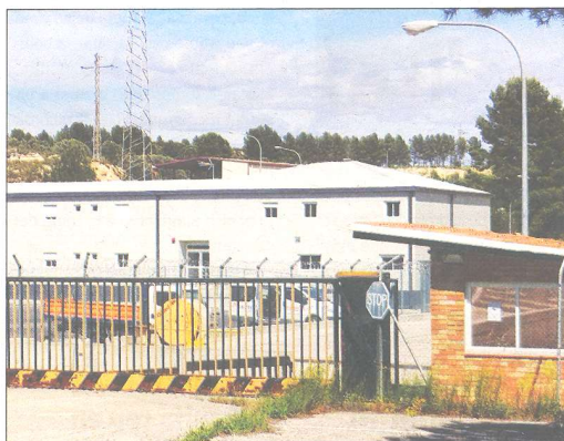
La caserna de la Guàrdia Civil s'ha construït sense permís d'obres. / L'EBRE
