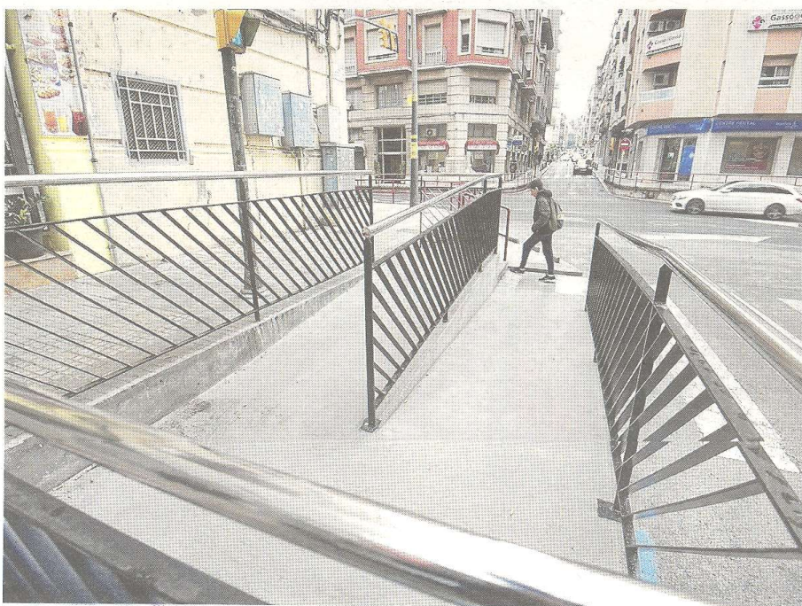
Imatge d'una de les obres executades arran la celebració dels pressupostos del 2017. FOTO: JOAN REVILLAS
