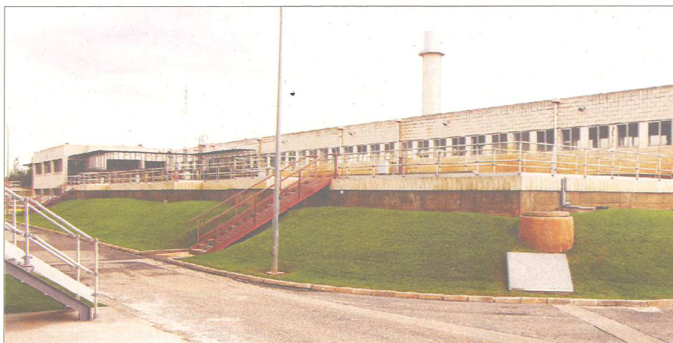
Imatge de les instal·lacions del CAT a la planta potabilitzadora de l'Ampolla. / ARXIU
