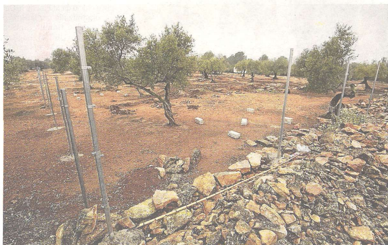
Imatge de l'espai on s'ubicarà ARCA, al terme d'Aldover. Un gran grup de persones, de forma voluntària, hi estan construint el nou refugi. FOTO: JOAN REVILLAS
