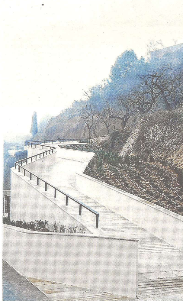
Imatge de la sendera, que s'ha recuperat respectant la topografia existent i aprofitant espais d'estança o miradors. FOTO: INCASÒL
