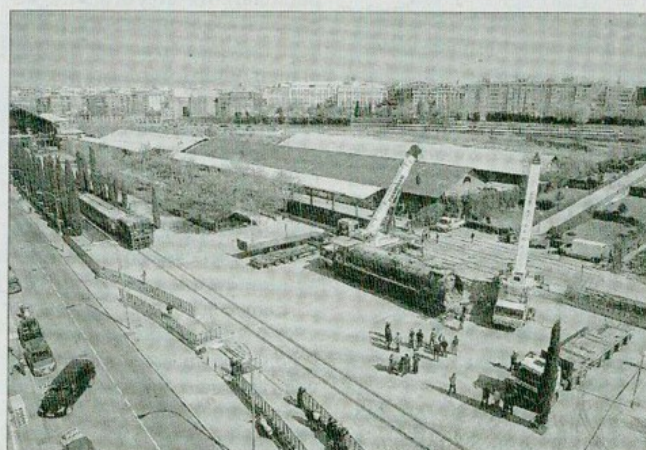
► Les dues grues de gran tonatge durant la maniobra. FOTO: FPPFI
