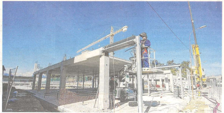
Les obres de la nova piscina de Tortosa. FOTO: JOAN REVILLAS
