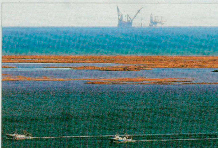
Obres a la planta marina del projecte Castor, davant del delta de l'Ebre. FOTO: JOAN REVILLAS
