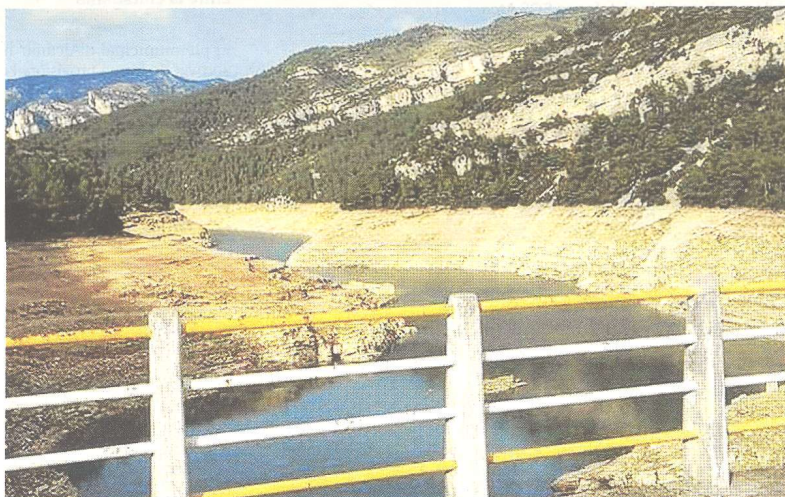
Imatge de l'estat actual de l'embassament d'Ulldecona. FOTO: CEDIDA
