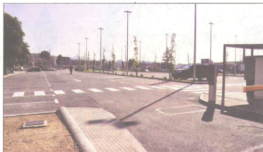
El bus llançadora, en una imatge difuminada amb les dades d'ús sobreimpressionades, i l'aparcament a l'entrada de Tortosa, gairebé buit. / N. CARO
