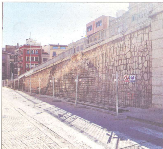
Una imatge recent del pont de l'Estat en obres, però sense gent treballant-hi.
