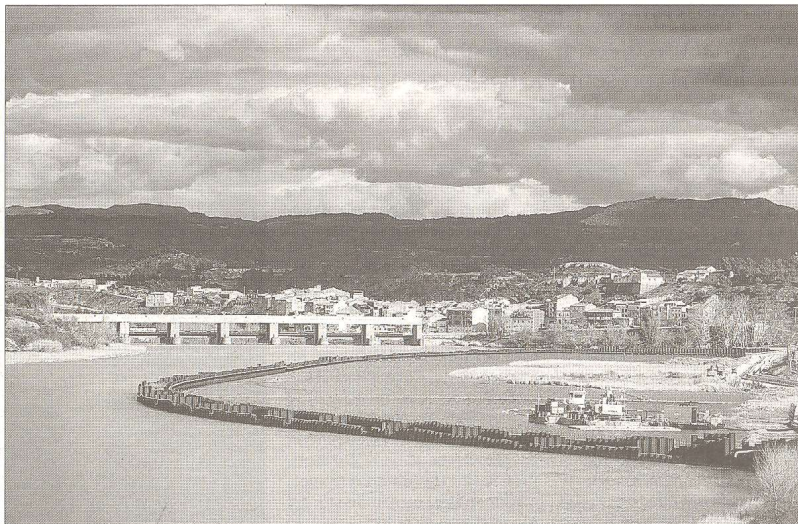
Imatge del mur de contenció aixecat fa anys per aïllar la zona contaminada. FOTO: JOAN REVILLAS
