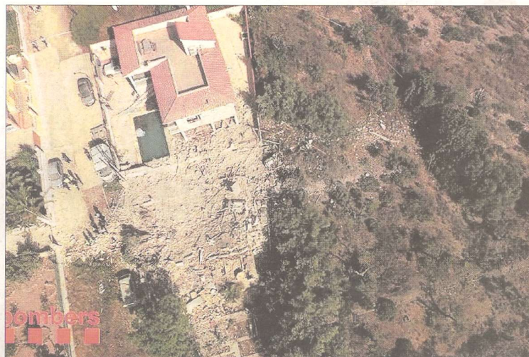
El xalet de la urbanització Montecarlo va quedar totalment destruït. FOTO: BOMBERS DE LA GENERALITAT
