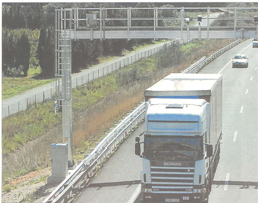
El radar de tramo en la AP-7, entre Uldecona y Amposta. Es el que más multa de Catalunya. FOTO: JOAN REVILLAS
