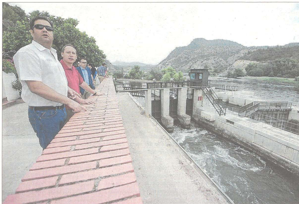
Visita a les instal·lacions de l'assut de Xerta, ahir al matí. FOTO: JOAN REVILLAS
