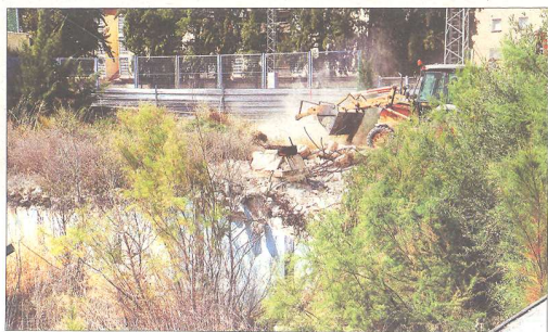
A dalt, imatge de l'anunci d'inici de les obres per part de l'alcalde, Ferran Bel, acompanyat de la regidora d'Urbanisme, Meritxell Roigé, i representants de l'empresa adjudicatària. A sota imatge de les màquines treballant. FOTOS: ACN
