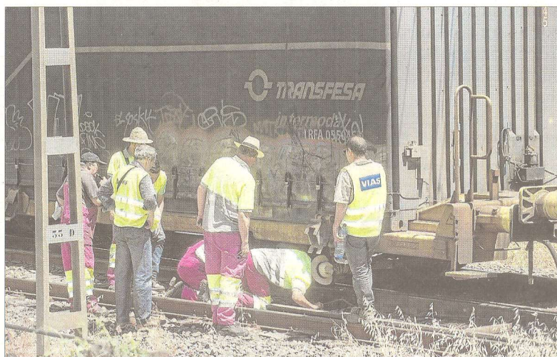
Operaris treballant en la descarrilament del tren, ahir al matí. FOTO: JOAN REVILLAS
