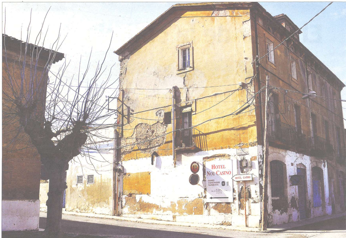
La colònia industrial, construïda a principi del segle xx, es troba en un estat de degradació important per falta de manteniment. NÚRIA CARO
