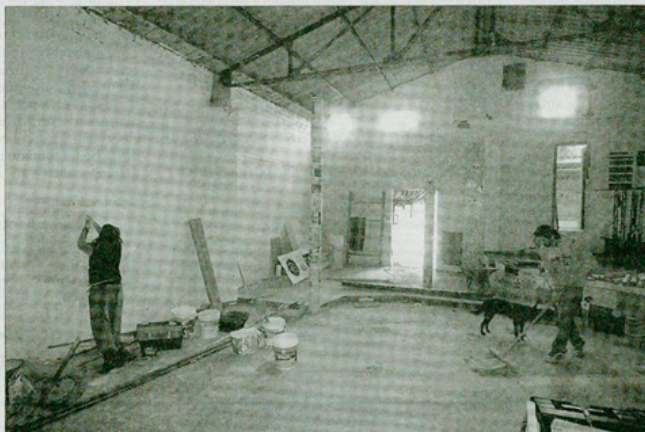
Imatge dels treballs de millora del centre social Lo Maset de Deltebre. FOTO: JOAN REVILLAS
