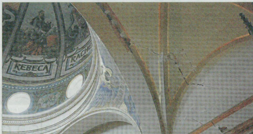
Les esquerdes afecten sobretot el creuer de la nau principal, on s'han col·locat testimonis per veure'n l'evolució ■ J.C. LEÓN
