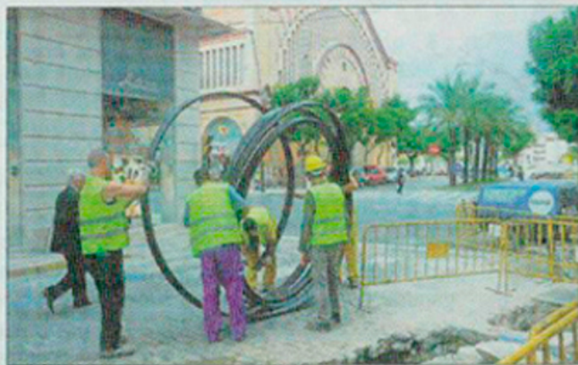
L'obra civil per desplegar la fibra òptica a Tortosa va començar a finals de l'any passat ■ ARXIU
