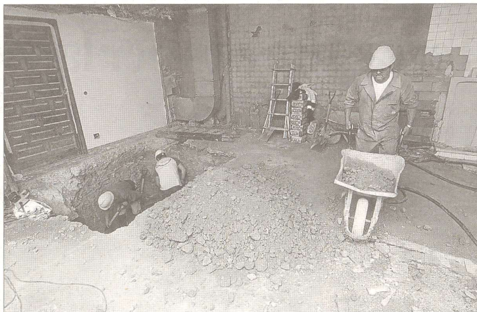
Els operaris treballant en un dels futurs ascensors de què disposarà el Parador de Tortosa. FOTO: JOAN REVILLAS
