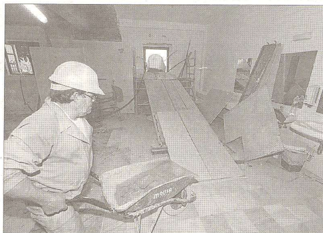
Els treballs de millora també estan renovant els serveis públics.
