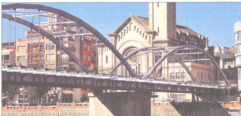
Imatge dels treballs al pont de l'Estat presa aquest dijous. / N. CARO
