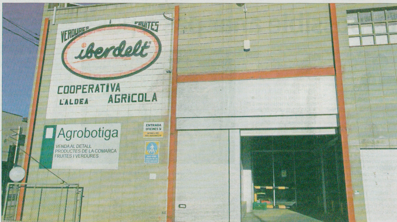
Façana de les instal·lacions de la cooperativa de l'Aldea, situades al costat de la carretera N-340 ■ DIMAS BALAGUER
