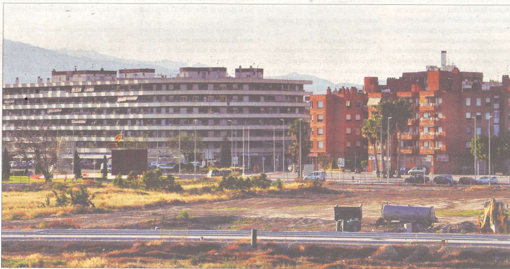
Una imatge recent de les obres d'urbanització del carrer de Ferran Arasa i, en general, de l'àmbit del Pla parcial Temple Sud. / N. CARO
